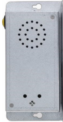
Bild 22 Lift 1 Steel Över
